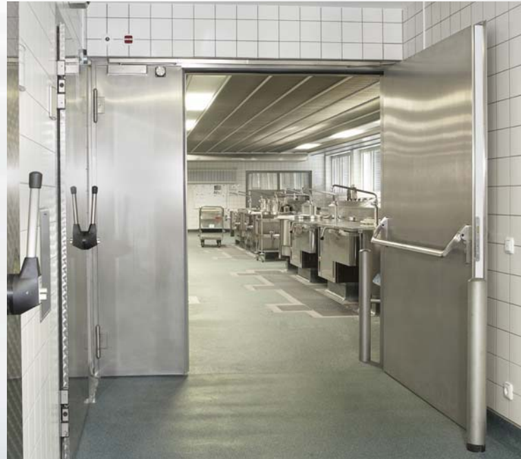
Feuerschutztür, 2-flügelig, geschliffene Oberfläche, in einer Großküche.
