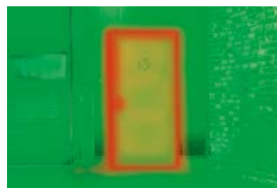
Sichtbarer Energieverlust ohne thermisch getrennte Tür
